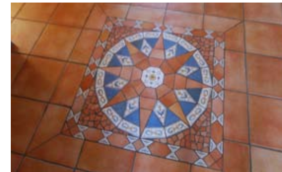
Detalj i gulv
